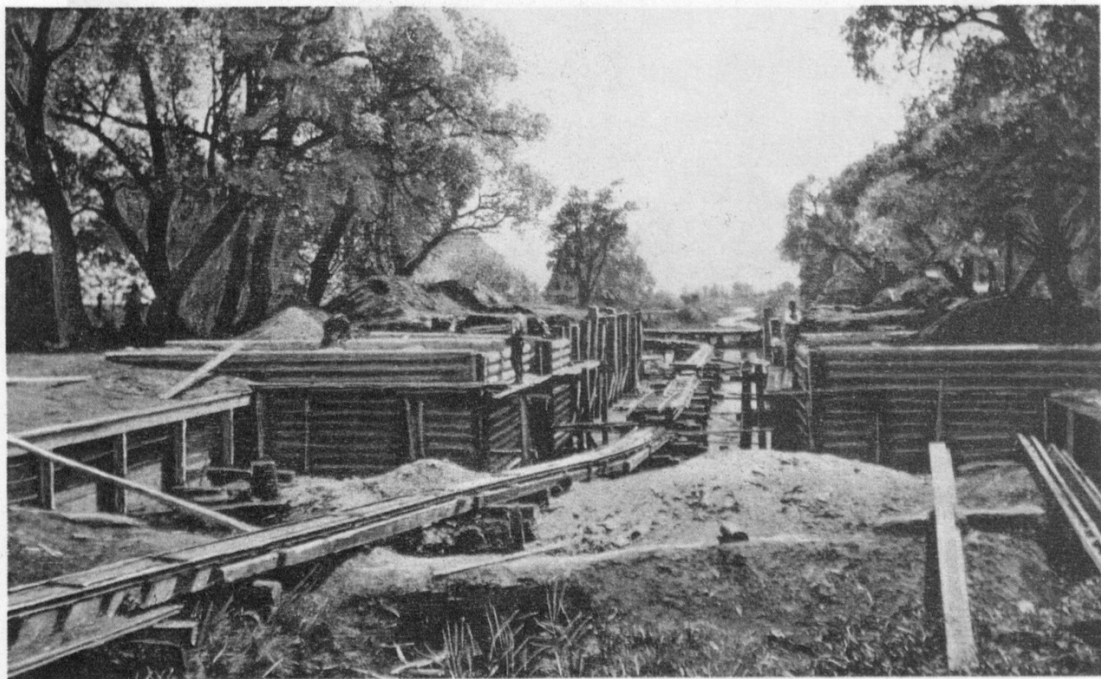
b. Górna głowa i komora śluzy kanału Ogińskiego podczas odbudowy.
