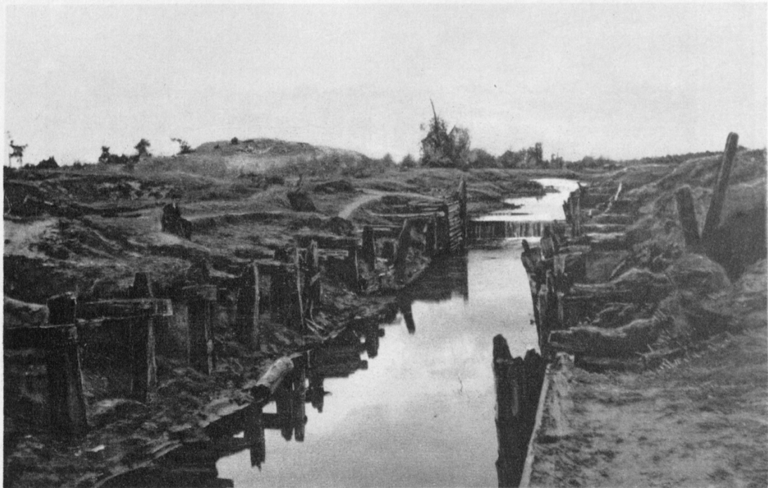
a. Śluza na kanale Ogińskiego od górnej głowy, przed odbudową.
